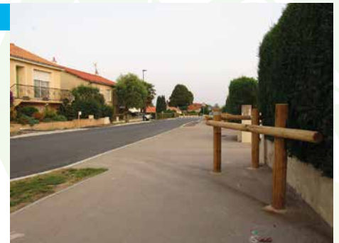
➔ Installation pour déporter les piétons et vélos et permettre aux riverains de sortir
